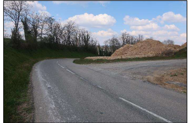
Accès au chemin d'exploitation depuis la RD 130 A et travaux de talutage réalisés Source : ARTIFEX 2021
